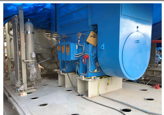
WEG 1600KW 6300 VOLT POMPA MOTORU
